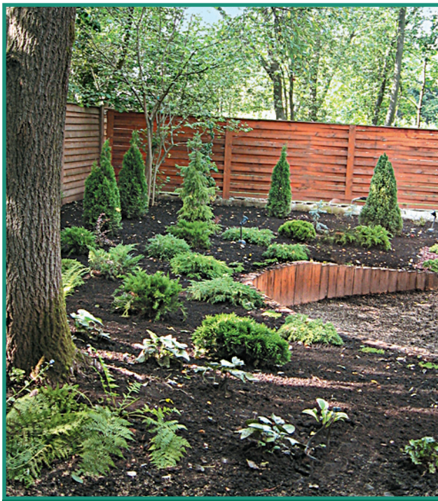
Для сооружения невысокой подпорной стенки используют круглые деревянные чурбачки
